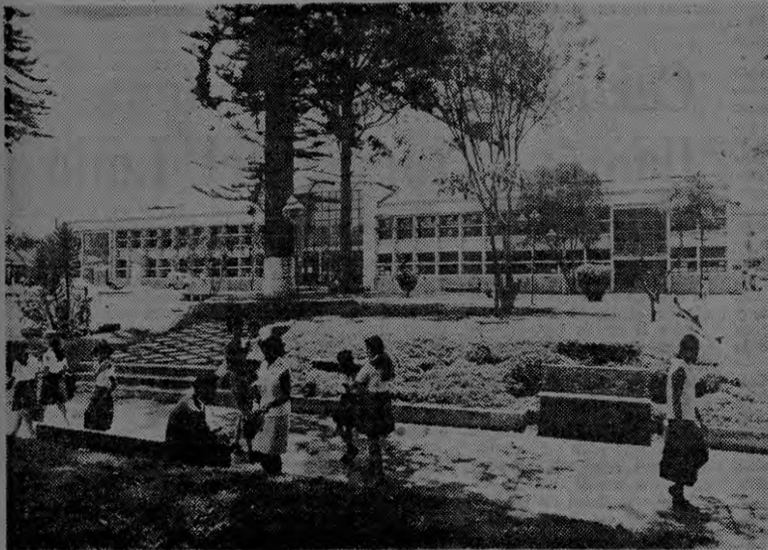
UN BELLO PARQUE, caracterizado por sus altos pinos, teniendo al frente las Oficinas de la Gobernación y Municipalidad de la Pro-
